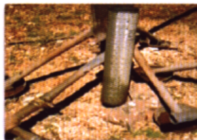
Fig. 63. Limpieza de los filtros.
