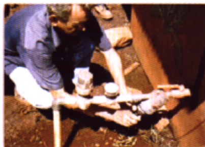
Fig. 63. Limpieza de los filtros.
