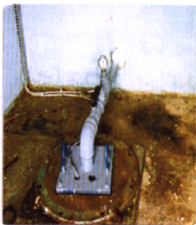
Fig.67. Motobomba sumergible con caseta, válvula de retención, manómetro, válvula de control y panel de control.
